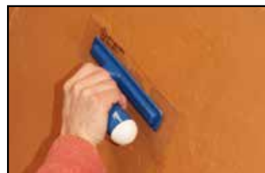
Étape 4 - à mi séchage, resserrer l'enduit à l'aide d'une spatule plastique souple.
