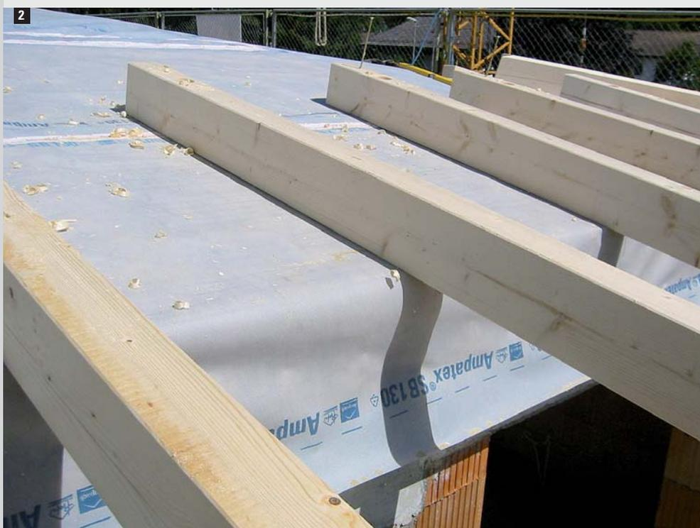
**1-3** Isolation sur chevrons avec Ampatex® SB 130. Collage des joints avec Ampacoll® XT.
