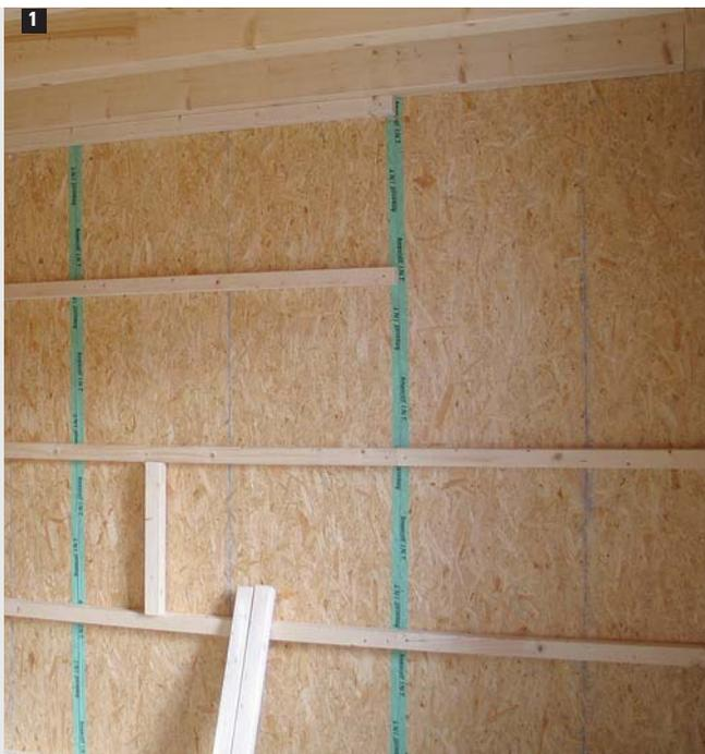
1 Fermeture étanche à l'air des joints entre panneaux OSB avec Ampacoll® I.N.T.
