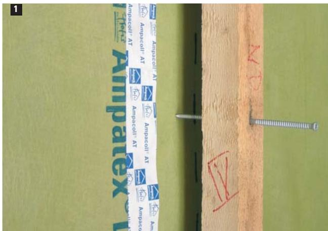
1 Ampatex® DB90, fermeture du joint avec Ampacoll® AT.
