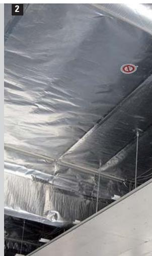
1/2 Pare-vapeur et couche d'étanchéité à l'air Sisalex™ 514 au plafond d'une piscine couverte.
