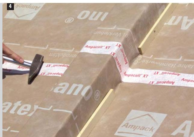
4 Ampatex® Resano® pare-vapeur à diffusion variable, fermeture des joints avec Ampacoll® XT.
