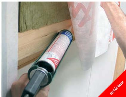
Colle liquide à base de caoutchouc synthétique pour la fixation des joints et des raccords des bordures des lés de sous-toitures et des pare-vapeur résistants aux intempéries. Utilisable à des températures d'application très basses.
